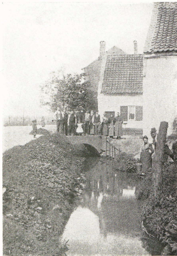
Le ruisseau Gelejsbeek le long de la chaussée de Neerstalle avant les travaux de voûtement.
